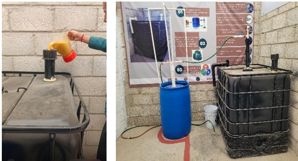
Ilustración 9 Mantenimiento del Biodigestor en CIDFORT
